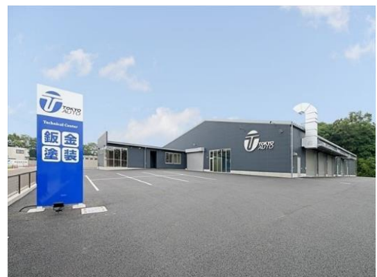
(仮称)東京オートテクニカルセンター新築工 事
