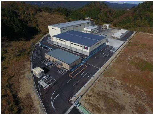
メルテックいわき株式会社 人工骨材製造設 備建設工事
