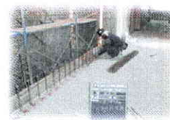
周囲パイプ配筋
