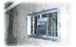
サッシ取付完了
