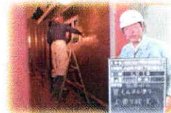
壁モルタル塗り状況
