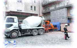
コンクリート打設状況
