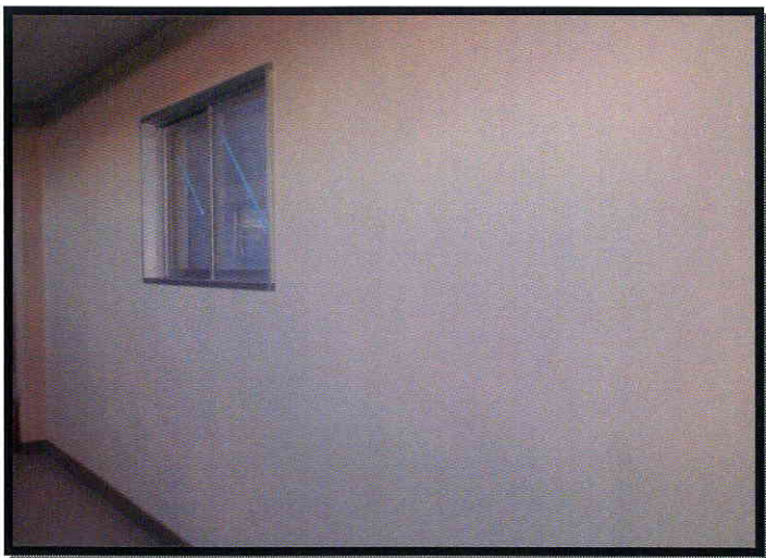
耐震壁増設部仕上げ完了
