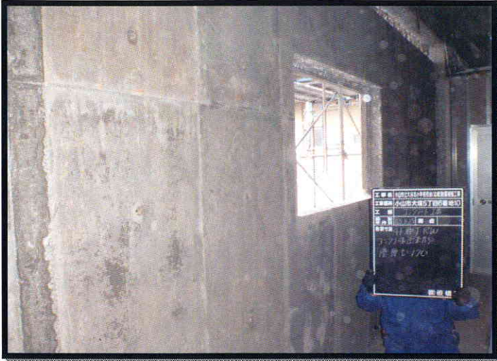
コンクリート(膨張材入り)打設完了
