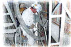
コンクリート打設状況
